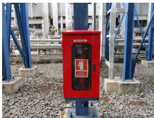
ภาพที่ 2-44 อุปกรณ์ดับเพลิงแบบมือถือ ชนิดสารเคมีแห้ง
