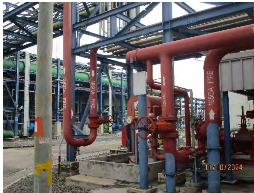
ภาพที่ 2-42 Diesel Engine Driven Fire Water Pump
