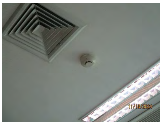
ภาพที่ 2-36 Smoke Detector
