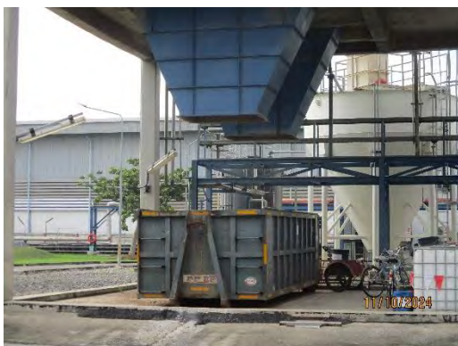
ภาพที่ 2-21 ระบบจัดเก็บตะกอนจากระบบปรับปรุง คุณภาพน้ำดิบ
